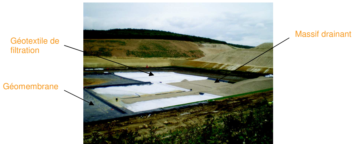
Figure 8 : Photo illustrant un chantier de mise en place d'étanchéité active
