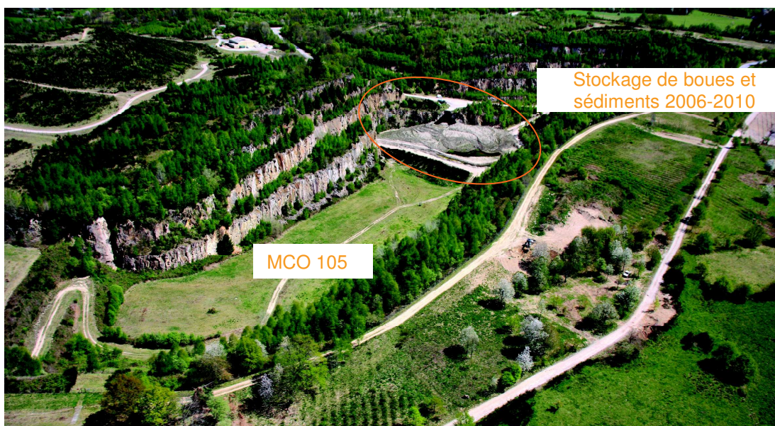
Figure 2 : Photo du stockage existant de boues et sédiments
