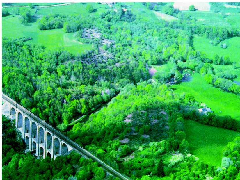
Figure 55 : Vue aérienne de la Gartempe et du viaduc de Rocherolles
